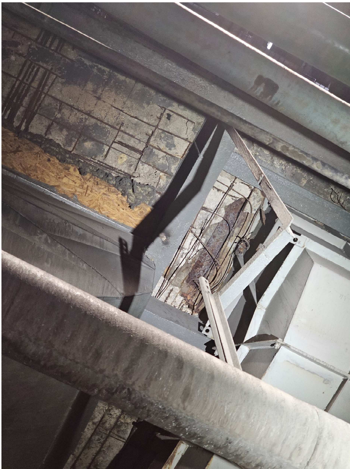
Fot. 5. Zdjęcie przedstawia widok dolnej powierzchni stropu w miejscu oparcia na stropie kanału technicznego – obszar „B” przy osi 6 wg części opisowej opracowania. Na zdjęciu widoczny bardzo duży ubytek betonu oraz skorodowane zbrojenie. Ubytek betonu jest na tyle duży, że widać przez niego skorodowaną blachę podstawy oparcia kanału. Na zdjęciu widać znajdujące się w powietrzu, odstające pręty zbrojeniowe.
