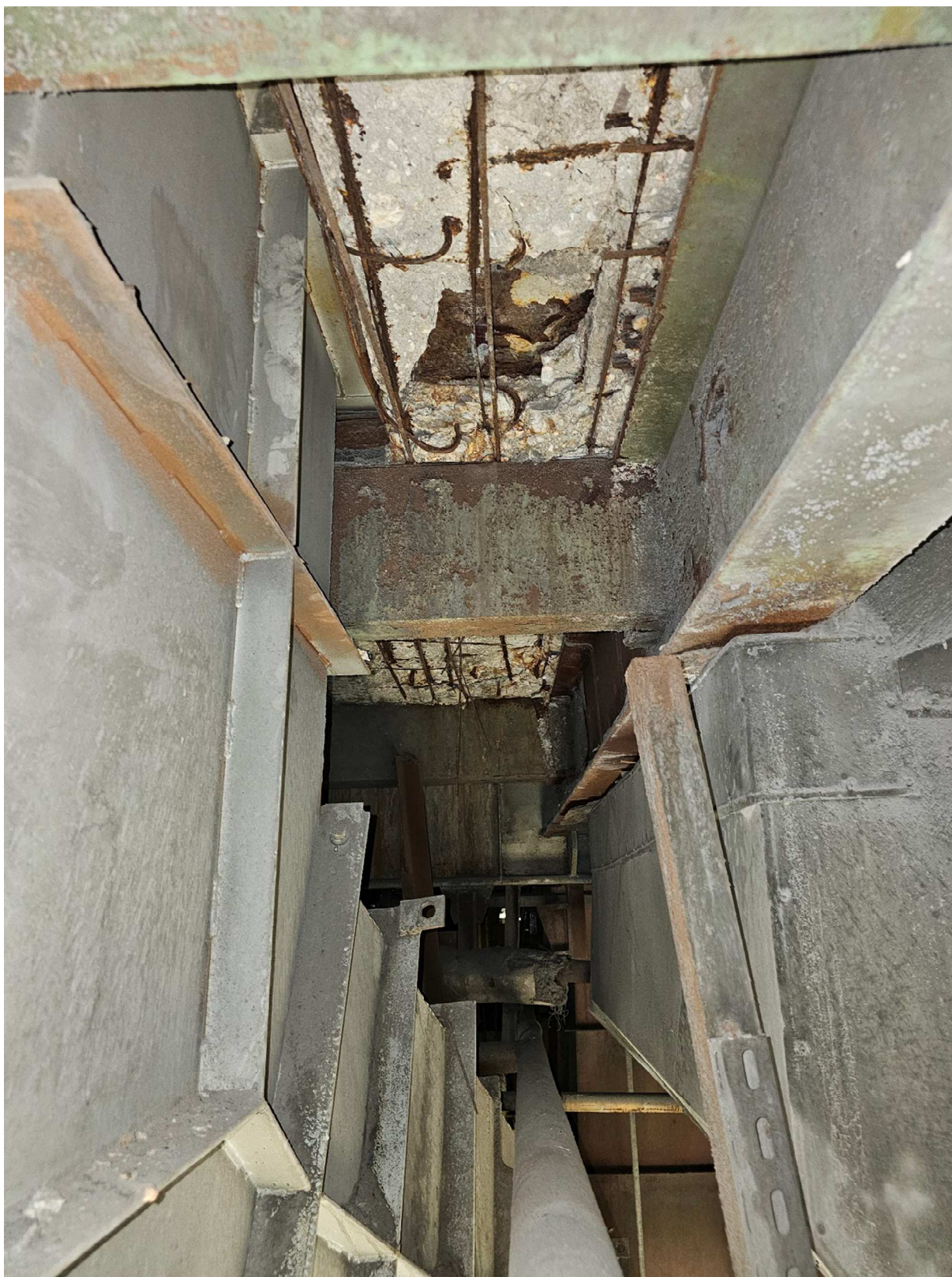
Fot. 2. Zdjęcie przedstawia widok dolnej powierzchni stropu w miejscu oparcia na stropie kanału technicznego – obszar „B” przy osi 2 wg części opisowej opracowania. Na zdjęciu widoczny bardzo duży ubytek betonu oraz skorodowane zbrojenie. Ubytek betonu jest na tyle duży, że widać przez niego skorodowaną blachę podstawy oparcia kanału.
